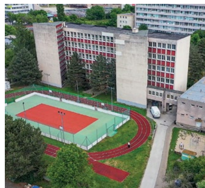
Obchodná akadémia, Račianska 107 pred rekonštrukciou
