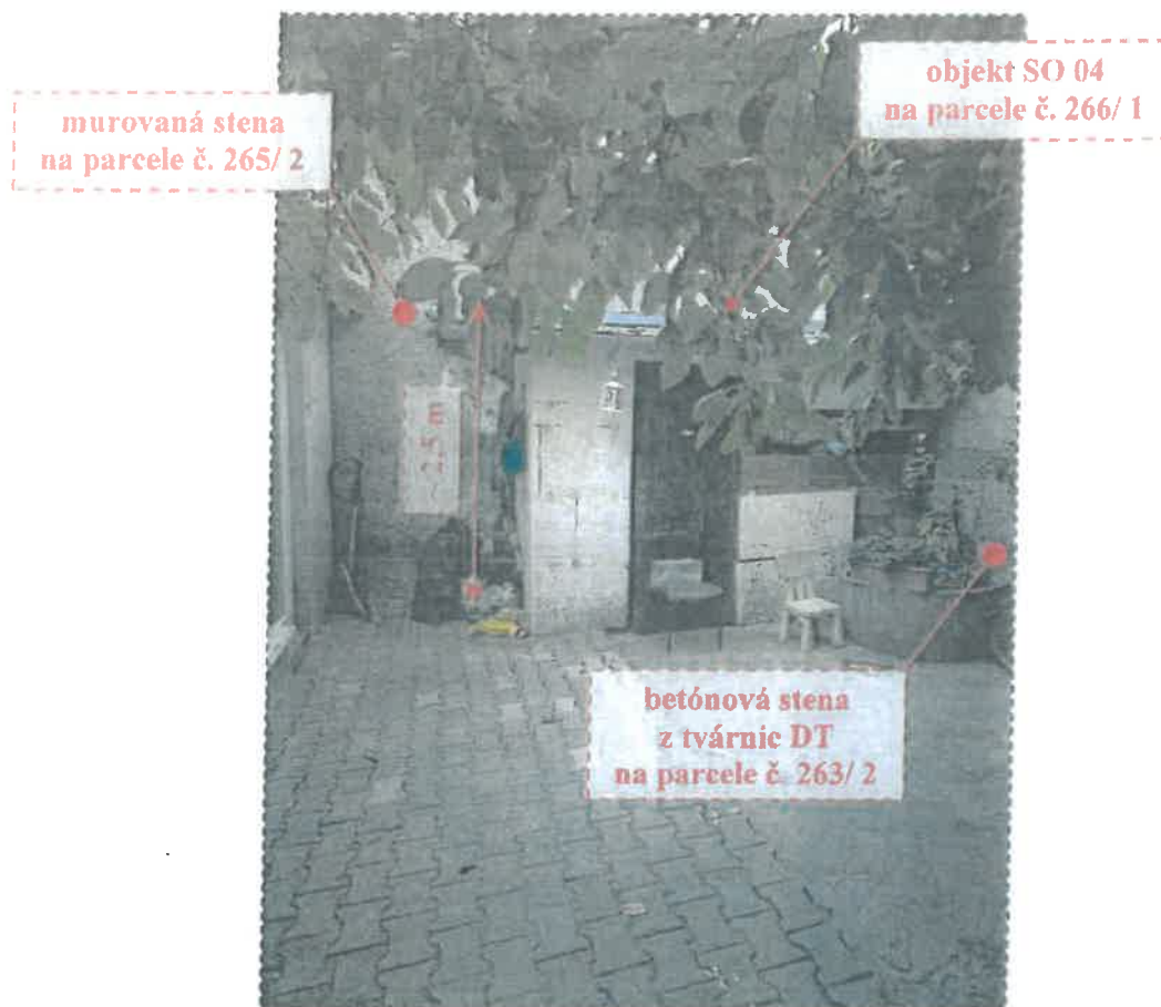
Obrázok č.18 Pohľad na objekt SO 04 na parcele č. 266/ 1 z roku 2025
