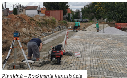
Pivničná – Rozšírenie kanalizácie
