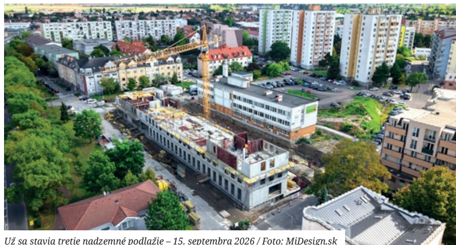
Už sa stavia tretie nadzemné podlažie – 15. septembra 2026 / Foto: MiDesign.sk
